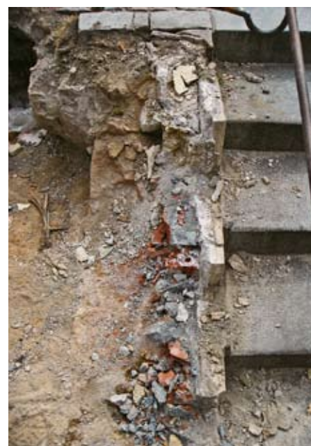
Obr. 12: Při opravě schodů na Kampu, prováděné na konci devadesátých let, byly za tenké pískovcové destičky kladeny příčné děrované cihly do cementové malty
