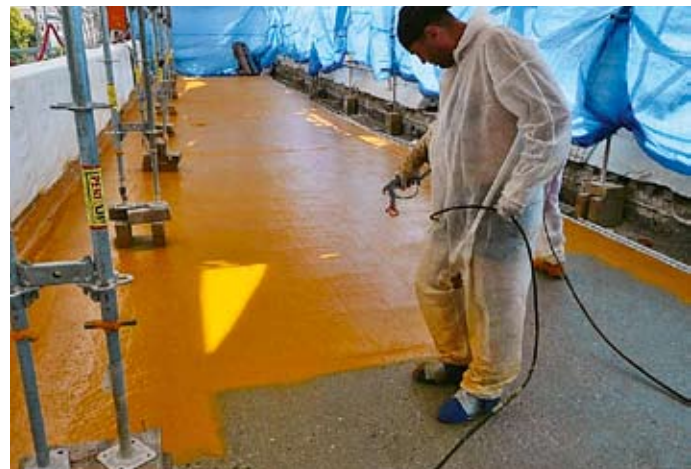
Obr. 16: Stříkání první vrstvy izolace
