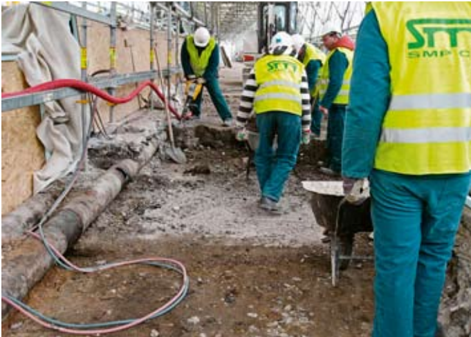
Obr. 13: Bourání vrstev z poslední opravy. V popředí je vidět hrana železobetonové desky, v části bližší k nám už nebyla
