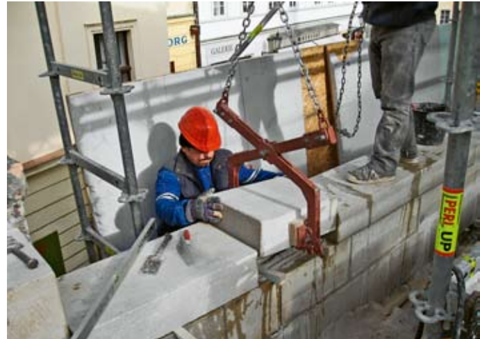
Obr. 14: Pokládání nového kamene
