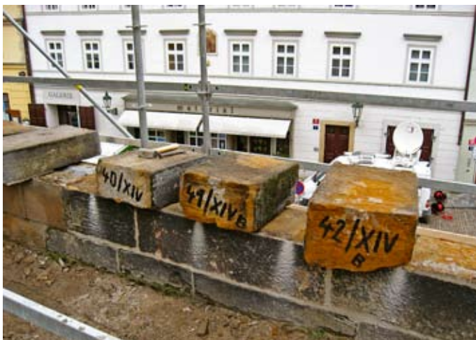
Obr. 8: Uvolněné a označené kameny
