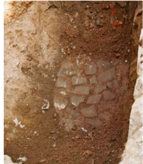
Obr. 5: Historická dlažba mostovky stará nejméně 300 let
