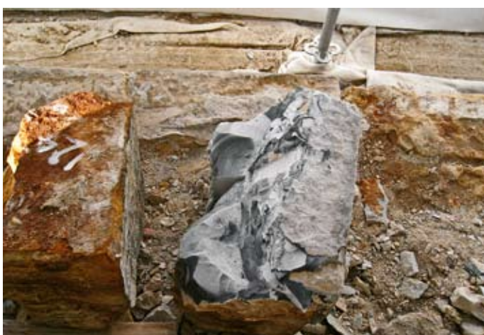
Obr. 10: Taky kámen. Za pískovcovou deskou je často injektážní směs.
