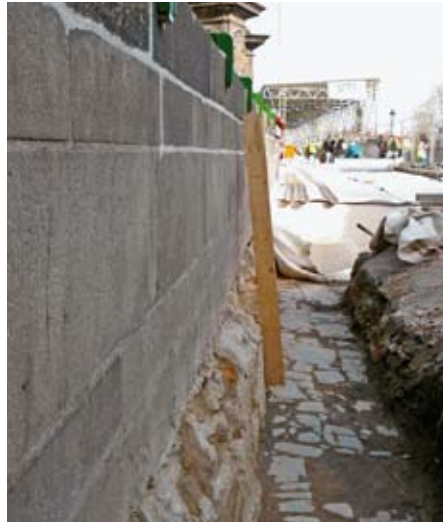
Obr. 4: Odkrytý barokní chodník
