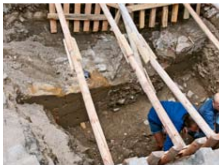
Obr. 1: Zdívo z 15. století, odkryté ve výkopu před malostranskou mosteckou věží
