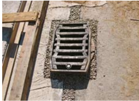
Obr. 19: Odvodňovač před položením dlažby, do něhož je drenážním plastbetonem přiváděna voda stékající po izolaci
