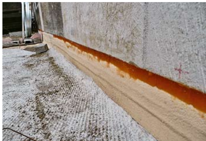
Obr. 18: Ukončení izolace ve vodorovné drážce vyplněné tmelem
