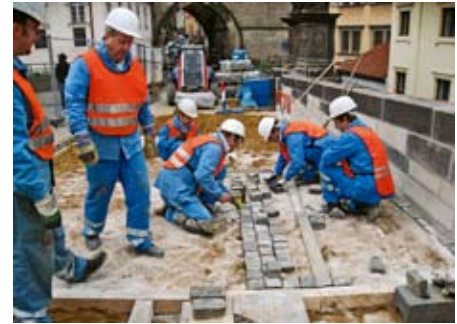
Obr. 20: Dlaždiči – poslední práce před uvedením do provozu
