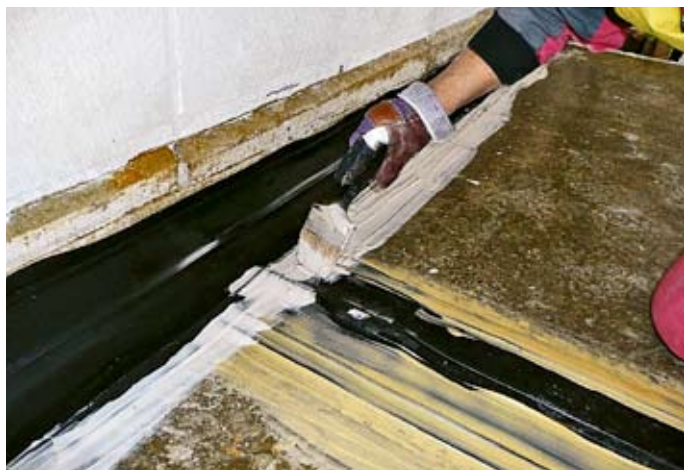
Obr. 17: Lepení dilatačních pásů
