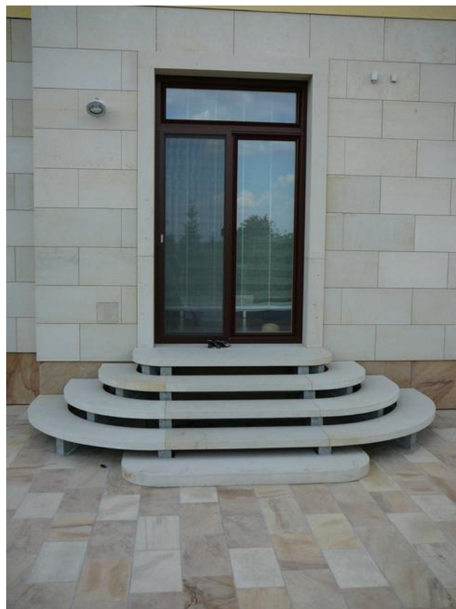
Pásová dlažba s obkladem a schody
